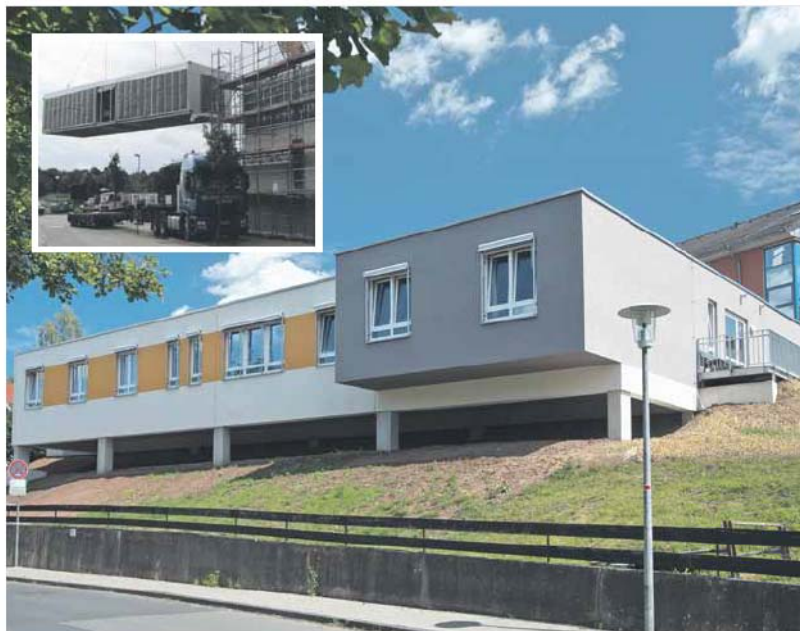
So funktioniert Modulbau: Am Bauplatz werden vorgefertigte Module zusammengesetzt, die in spezialisierten Werkhallen erstellt wurden. Das große Bild gibt ein Beispiel der Architektur eines im Modulbau konstruierten Hauses nach der Fertigstellung. Foto: Immotec
