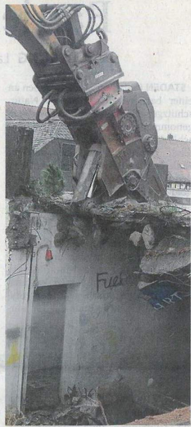
Der Betonabbruch wird in der Nähe der Kläranlage Wenings aufbereitet werden.
